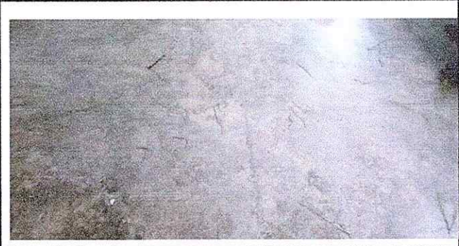
MODULO 2: PISOY TORTA DE CEMENTO
