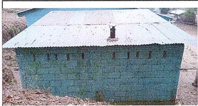
MODULO 1: CUBIERTA DE LAMINA
